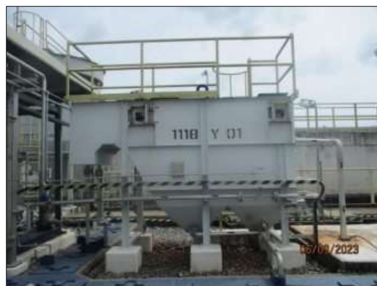
รูปที่ 2-18 หน่วย Flotation unit เพื่อให้ไขมันที่เหลือน้ำที่เหลือแยกตัวออกจากน้ำ
