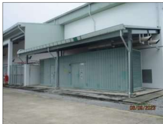
รูปที่ 2-62 เครื่องยนต์ดีเซลที่ใช้ขับเคลื่อนกำเนิดไฟฟ้าที่มี การติดตั้งแผ่นปิดล้อมกันเสียง และระบบ Exhaust silencers
