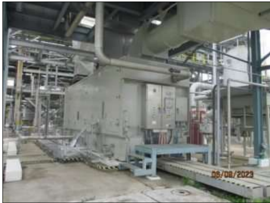
รูปที่ 2-10 การปิดล้อมกันเสียงจากเครื่องยนต์กังหัน กระปุกเกียร์ (Gearbox) และเครื่องกำเนิดพลังงาน
