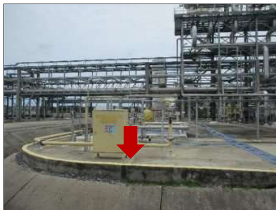
รูปที่ 2-27 คับปูกันระหว่างพื้นที่กระบวนการผลิต กับพื้นที่ส่วนอื่น ๆ
