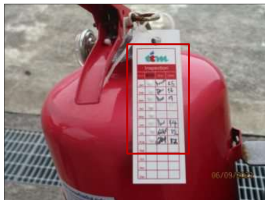
รูปที่ 2-45 การตรวจเช็คสภาพถังดับเพลิงเป็นประจำทุกเดือน
