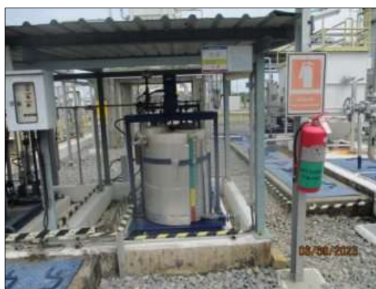
รูปที่ 2-24 การเติมสารเคมี Flotation agent เพื่อเพิ่มประสิทธิภาพในการแยกน้ำมันที่เหลือ ออกจากน้ำ
