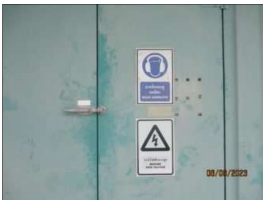
รูปที่ 2-49 การติดป้ายเตือนให้สวมใส่อุปกรณ์ป้องกันภัยส่วนบุคคลก่อนเข้าไปภายในพื้นที่ที่มีเสียงดัง
