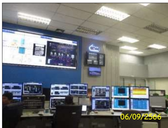
รูปที่ 2-58 การควบคุมและตรวจสอบระบบท่อส่งก๊าซโดยผ่านระบบ SCADA
