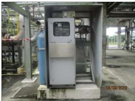
รูปที่ 2-59 Online Mercury Analyzer ที่ทางออกของหน่วยกำจัดปรอทที่โรงแยกก๊าซฯ
