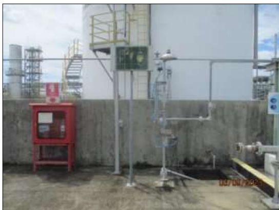
รูปที่ 2-50 ติดตั้งฝักบัวฉุกเฉิน ที่ล้างตาฉุกเฉิน บริเวณโรงแยกก๊าซธรรมชาติ ไทย-มาเลเซีย
