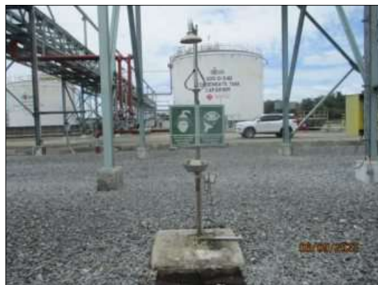
รูปที่ 2-50 ติดตั้งฝักบัวฉุกเฉิน ที่ล้างตาฉุกเฉิน บริเวณโรงแยกก๊าซธรรมชาติ ไทย-มาเลเซีย
